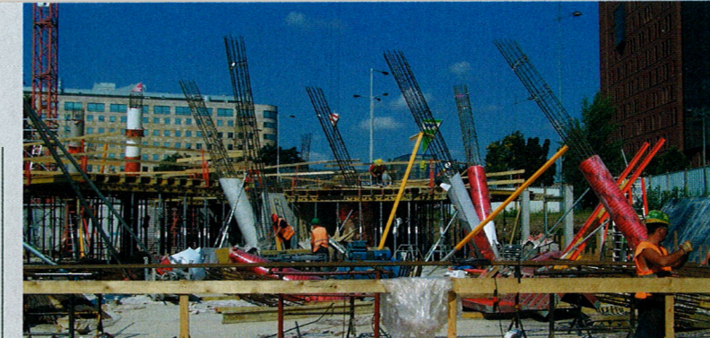
▲ Realizace šikmých sloupů
