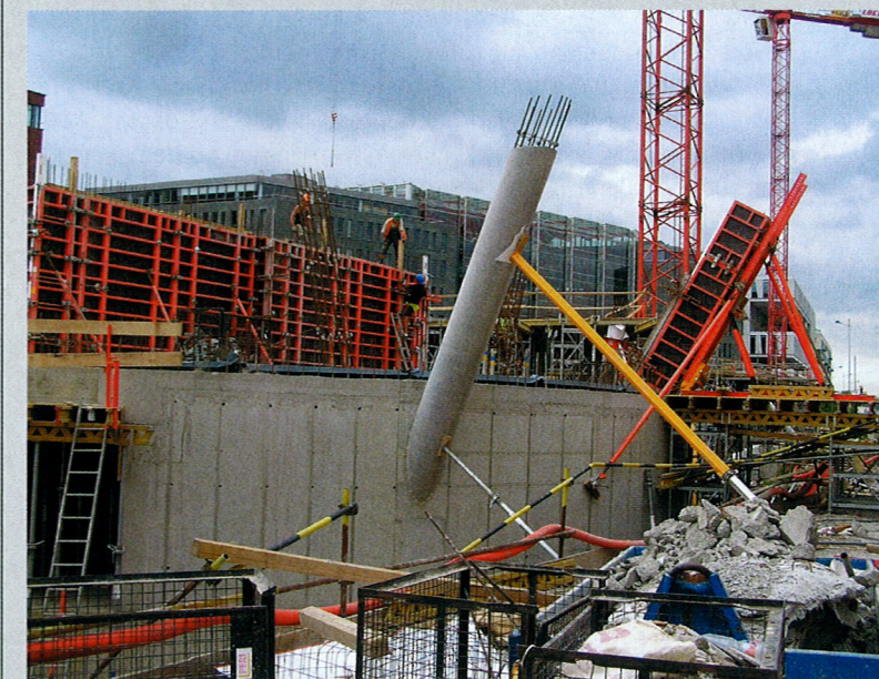
▲ Pohled ze západu na rozestavěnou budovu
