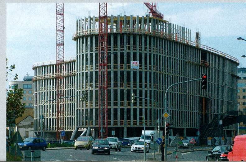
▼ Pohled na rozestavěnou budovu
