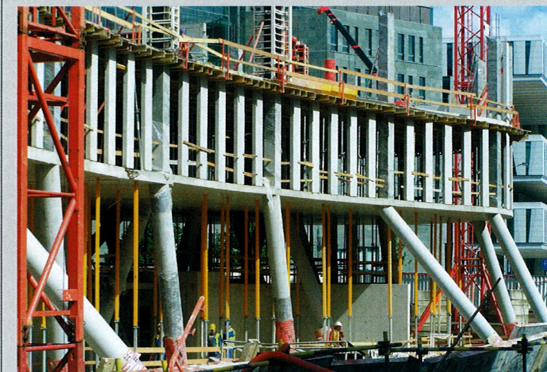
▲ Pohled z jihu na rozestavěnou budovu
