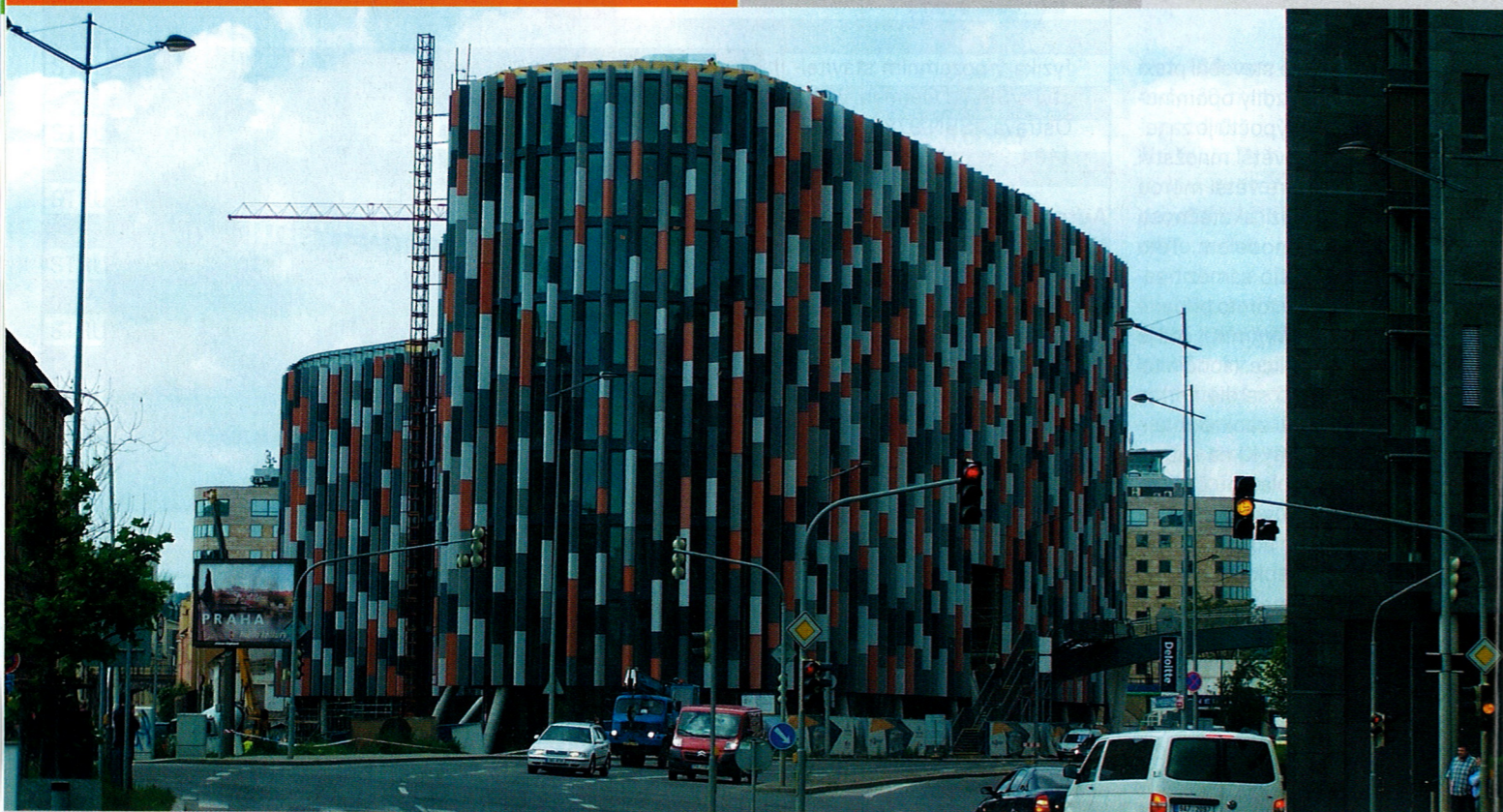
▲ Pohled na stavbu Main Point Karlín před dokončením v červnu 2011
