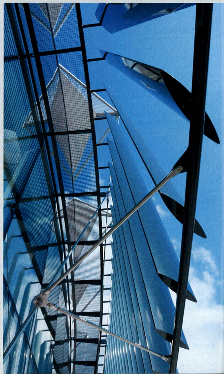
▼ Prosklená fasáda foyer se stínícími lamelami – detail, foto: Richard Davies
