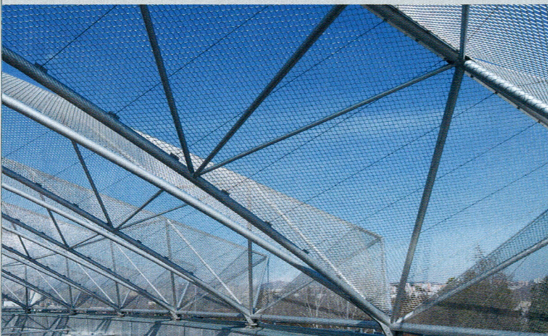
▲ Krytá ocelová konstrukce stavby je opláštěna hliníkovým tahokovem, foto: Richard Davies
