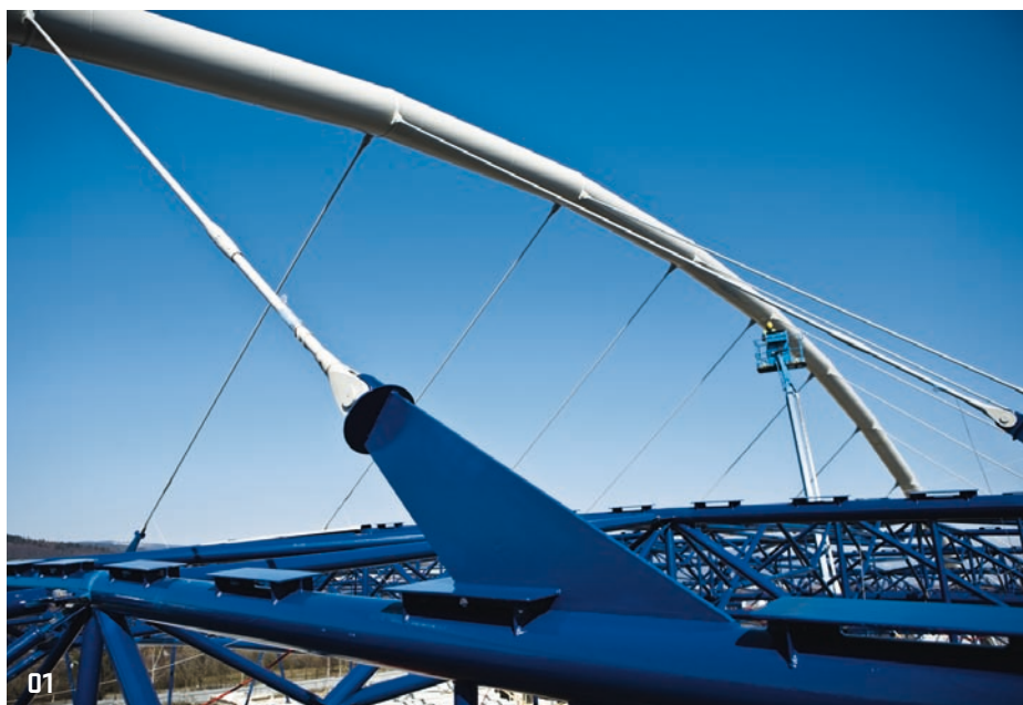
01 &gt; Páteří nosný oblouk pro zavěšení střechy
