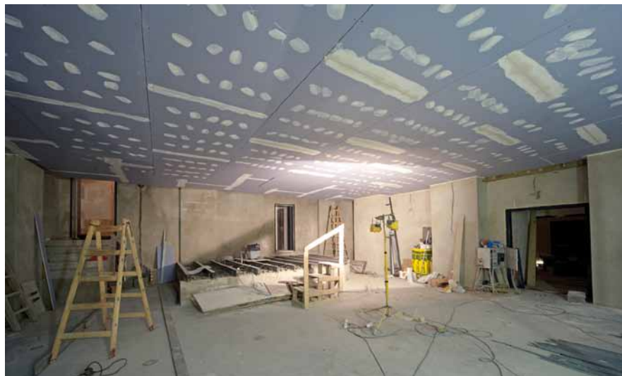
Dokončení sádkrotonového podhledu s dvouvrstvým opláštěním modrými akustickými deskami Rigips
