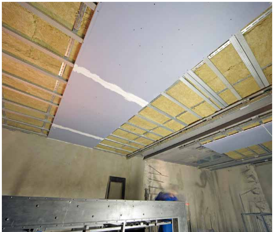
Přidané profily v nosném roštu umožňují dodatečné zavěšení vzduchotechniky a osvětlení s únosností až 200 kg na jeden závěs.
