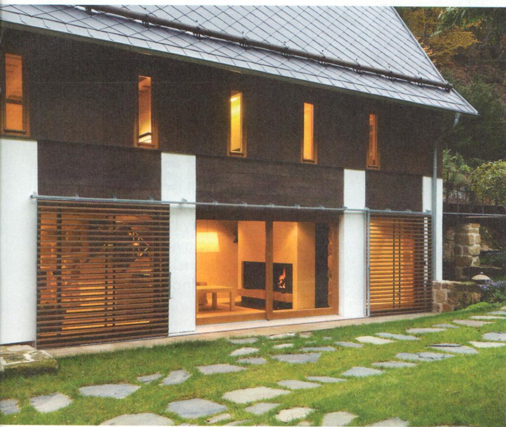
Maximální propojení vnitřního prostoru s venkovním. Velkoformátová okna částečně kryjí dřevěné žaluzie evokující vrata od stodoly.
