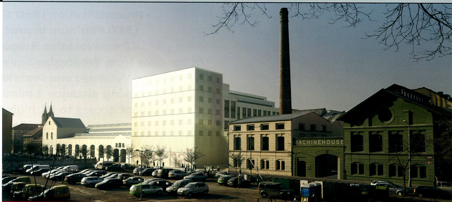
Karlin Halls, Praha 8 – Karlín – budoucí centrála vydavatelství Economia a novostavba s kanceláři a víceúčelovou halou ■ Zdroj: AED project
