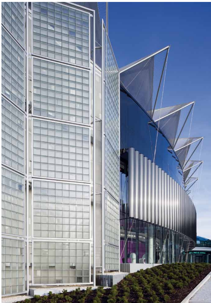
Zděnou část stavby kryje předsazená fasáda ze skleněných tvárníc, stínění prosklené části zajišťují vertikální lamely s profilem křídla.
