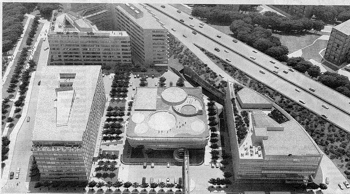
VZNIKÁ NOVÉ MĚSTO. Komplex budov Alpha, Beta, Gamma a Nové Brumlovky, které vzniknou nebo již stojí v Michli v těsné blízkosti severojižní magistrály. VIZUALIZACE: 3X PASSERINVEST GROUP
